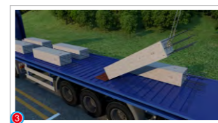
2 预制柱翻身起吊
