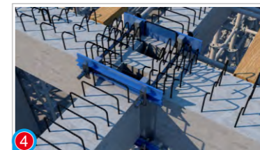
4 主次梁接头封堵
