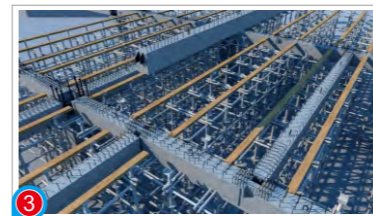
3 次梁起吊安装
