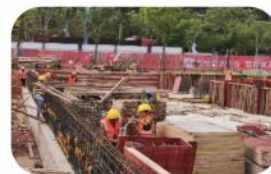
现场循环利用
