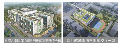
香港古洞北第29区特建福利服务综合楼 模块类型: 混凝土 模块数: 1764个 面积: 4万㎡ 深圳航城街道三围学校(一期) 模块类型: 混凝土 模块数: 281个 面积: 2.94万㎡
