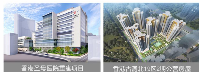
香港圣母医院重建项目 模块类型: 钢结构 模块数: 632个 面积: 4.9万㎡ 香港古洞北19区2期公营房屋 模块类型: 混凝土 模块数: 6314个 面积: 22.7万㎡ 项目高度: 152米
