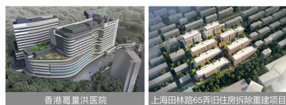
香港葛量洪医院 模块类型: 钢结构 模块数: 3705个 面积: 15万㎡ 上海田林路65弄旧住房拆除重建项目 模块类型: 混凝土 模块数: 2510个 面积: 7.1万㎡
