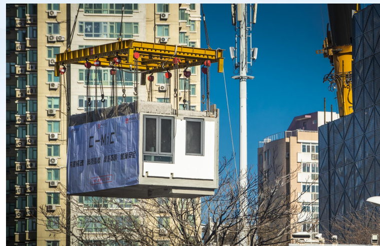
现场吊装施工
