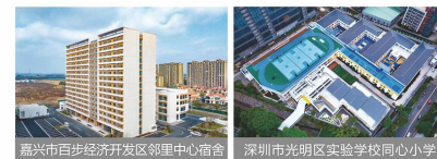
嘉兴市百步经济开发区邻里中心宿舍 模块类型: 混凝土 模块数: 384个 面积: 1.8万㎡ 深圳市光明区实验学校同心小学 模块类型: 钢结构 模块数: 338个 面积: 2.5万㎡
