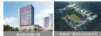
烟台莱山凤凰大厦 模块类型: 钢结构 模块数: 352个 面积: 11.7万㎡ 安徽省广德市科创实验学校 模块类型: 混凝土 模块数: 828个 面积: 4.4万㎡
