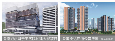
香港威尔斯亲王医院扩建大楼项目 模块类型: 钢结构 模块数: 2424个 面积: 29.7万㎡ 香港安达臣道公营房屋 (P2-6, P2-7) 模块类型: 混凝土 模块数: 4065个 面积: 5.16万㎡
