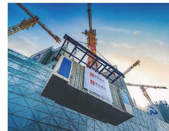
MiC模块现场吊装施工
