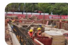
现场循环利用
