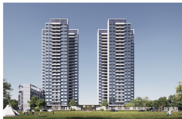
广州南沙大涌安置房项目
