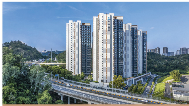
深圳华章新筑保障性住房项目
